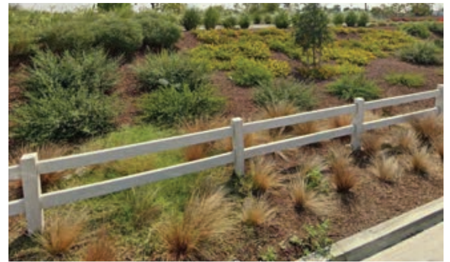
C PRECAST CONCRETE SPLIT RAIL FENCE SCALE: N.T.S.
