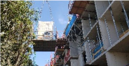
La aplicación de este proyecto es el montaje en obra del baño ya terminado, el cual llega a la faena con todos los artefactos instalados y completamente montados, disminuyendo así prácticamente a cero la generación de residuos en etapa de construcción de los baños.
