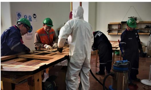
En los inmuebles que van a ser demolidos, se asigna un tiempo donde una cuadrilla especializada retira manualmente (utilizando algunas herramientas livianas) elementos tales como: maderas nobles y nativas, pisos de maderas, parqué, ventanas, estructuras metálicas, quincallerías, y todo aquello que pueda ser retirado para ser reutilizado, con el objetivo de reducir los residuos de demolición de los proyectos.
