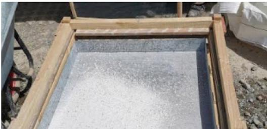
Mediante una máquina chipeadora que pertenece a Axis, los trabajadores adaptaron una mesa de madera como soporte y colocaron un contenedor abajo del soporte, el cual recibe el yeso-cartón molido. Esto permite reducir considerablemente su volumen, lo que significa ahorrar en transporte y disposición final. Pero además de eso, la mayor ganancia es volver a darle uso a un residuo que prácticamente no tiene salida para su reciclaje.
